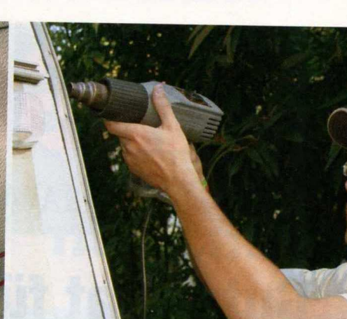
5 Gefühlssache: Die Kantenleiste muss ordentlich geheizt werden, sonst wird der alte Kleber nicht weich.
