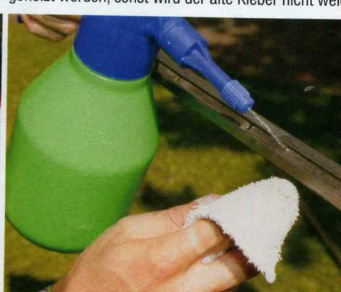
8 Feinarbeit: Geringe Kleberreste lassen sich auch mit Silikonentferner schnell wegwischen.
