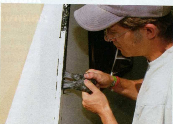
7 Geduldssprobe: Die alte Dichtmasse wird mit dem gleichen Material komplett abgezupft.
