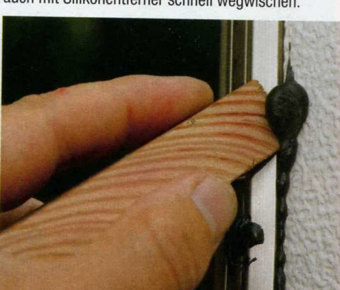
11 Abziehen: Nach drei Tagen lässt sich überstehender Kleber mit einem Holzkeil abtrennen.
